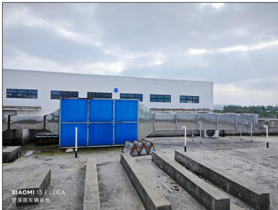
图 4.4-1 油烟净化装置
