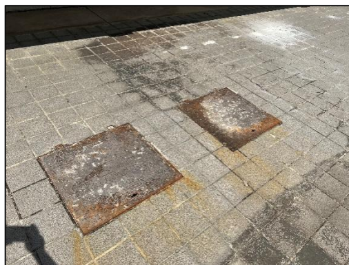
图 8-5 政务中心主变电所化粪池
