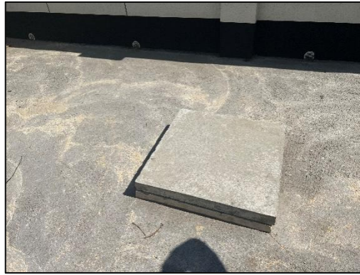
图 8-3 政务中心主变电所事故油池
